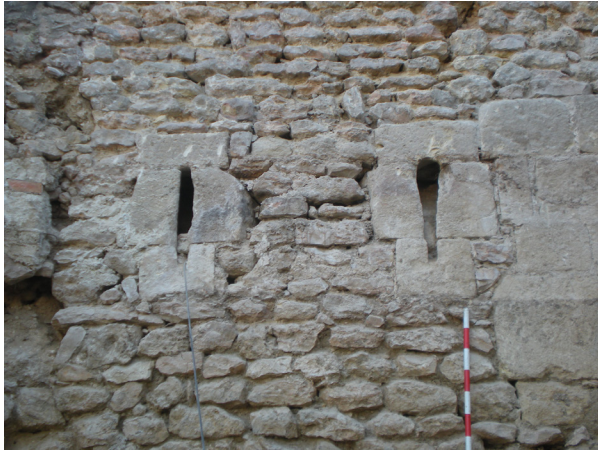
Figura 6. Detall de dues de les espitlleres associades al portal
